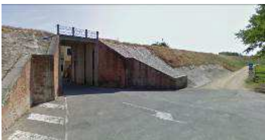
Porta di accesso alla golena del Piave dal centro di Noventa
