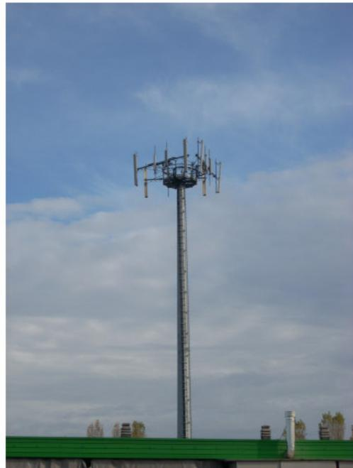
I valori di campo elettrico rilevati non hanno portato, in nessuno dei punti di misura, al superamento del valore di attenzione fissato pari a 6 V/m dal D.P.C.M. 8 luglio 2003; non si è riscontrato nemmeno il superamento del 75% di questo valore, evento che avrebbe comportato il ricorso a particolari misurazioni a "Banda Stretta" (selettive in frequenza).
